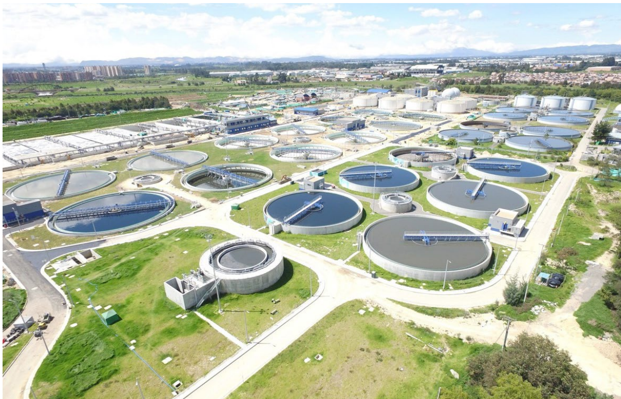
Figura 4. Progreso en la PTAR Salitre en 2021
